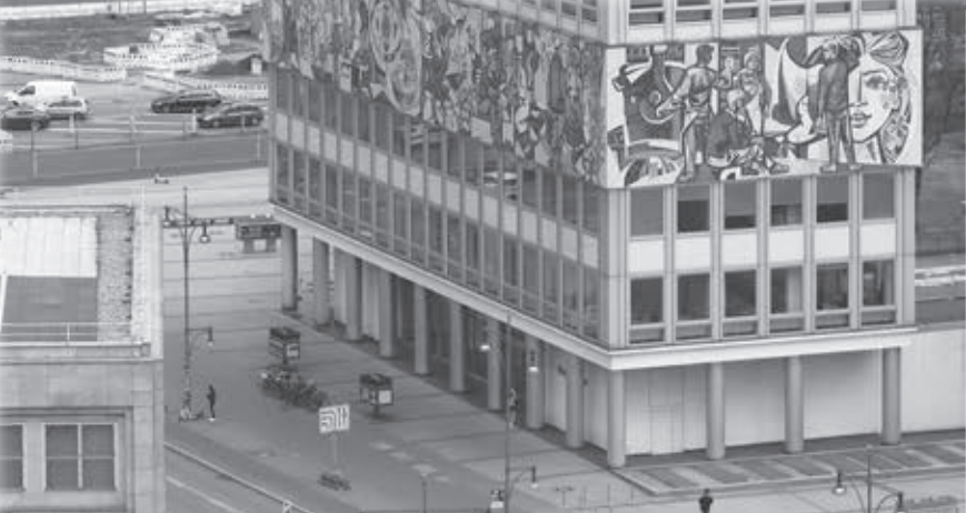
Blick auf das Haus der Statistik/Allessandersplatz, Foto: Erik Göngrich, 2021
